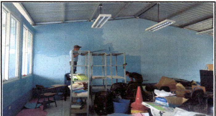
Foto 4: se indentifica el avance de la aplicacion de pintura en el interior del instituto
