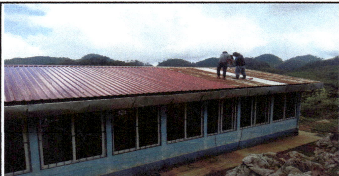
Foto 5: se observa el lijado de las laminas
