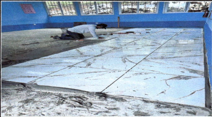
Foto1: se indentifica el avance de instalacion de piso ceramico aula i
