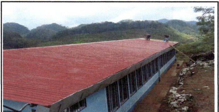
Foto 6: Se evidencia la aplicacion de pintura anticorrosiva
